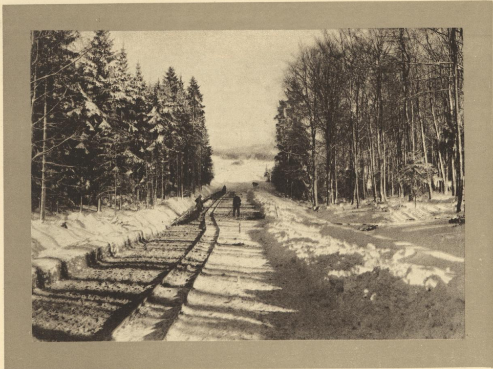
Der Nürburg-Ring bei der Antoniusbuche. Waldstück vor dem Ziel zwischen Nürburg und Meuspath (im Bau).
