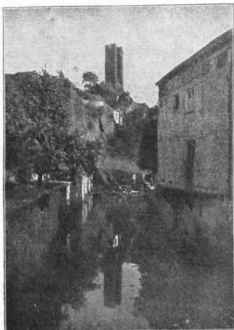
Beilsturm in Neuerburg.
