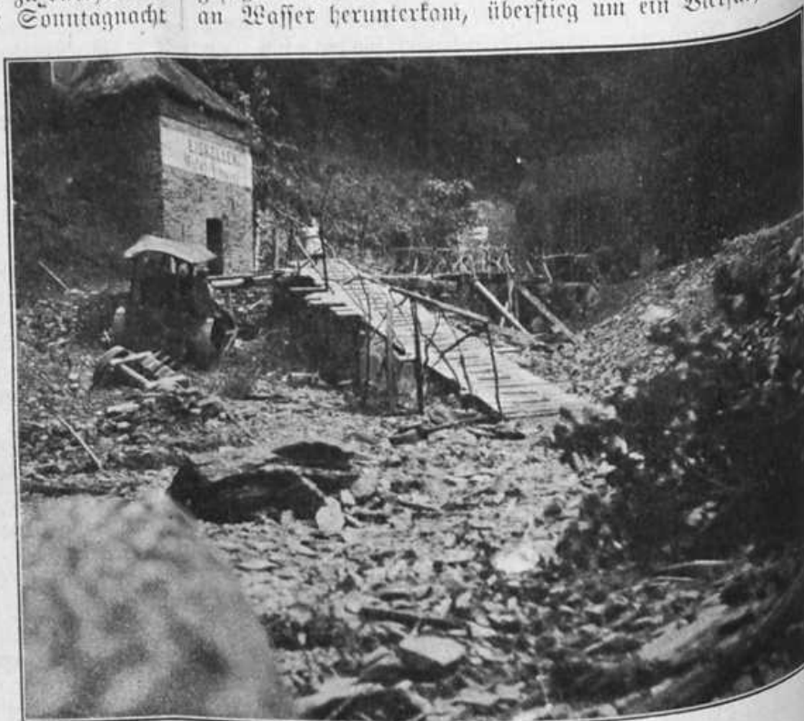
Von Pionieren erbaute Notbrücke bei Altenahr. Phot. Theo Schafgans, Bonn.
