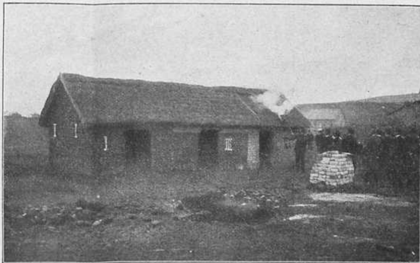
Brandprobe am 8. Oktober 1911 in Niederprüm. Flugfeuer, schon 10 Minuten auf dem Gernensdache, ohne zu zünden. Aufgenommen von Regierungsbaumeister Zengeler in Bonn.
