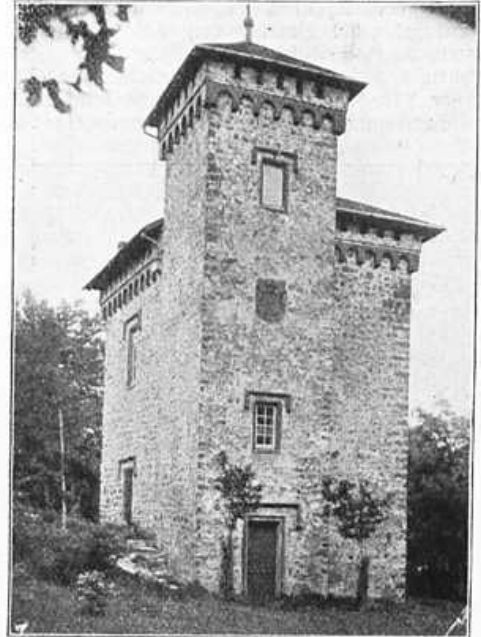
Der Turm auf dem Aremberg, an der Stelle des herzoglichen Stammschlosses erbaut. — Ausg. v. Kaver Neek in Blankenheim.
