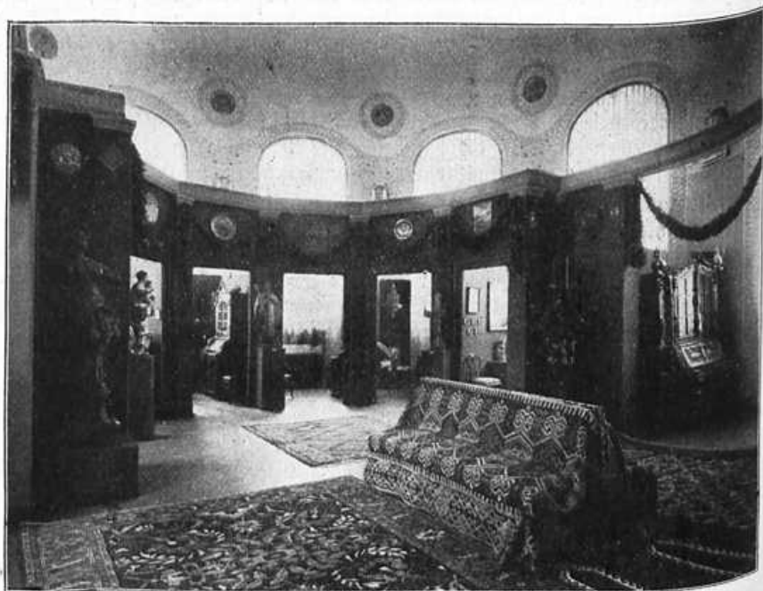
Säulen-Architektur in der Aula mit anschließenden Kojen. Entwurf von Architekt Lony, Lehrer an der Kunstgewerbeschule zu Trier.
