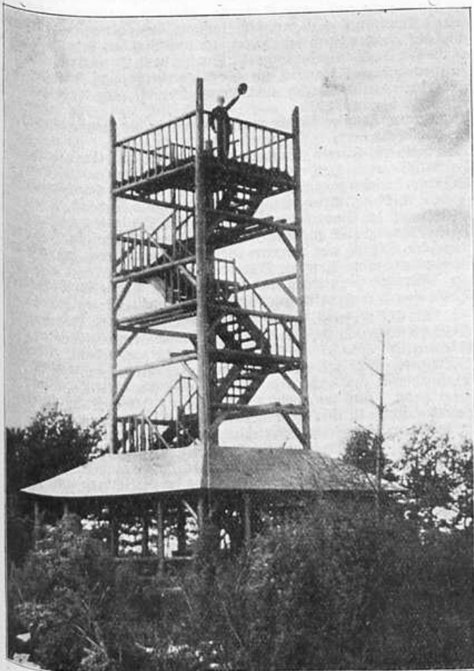
Schutzhütte mit Aussichtsturm auf der breiten Heide bei Adenau.
