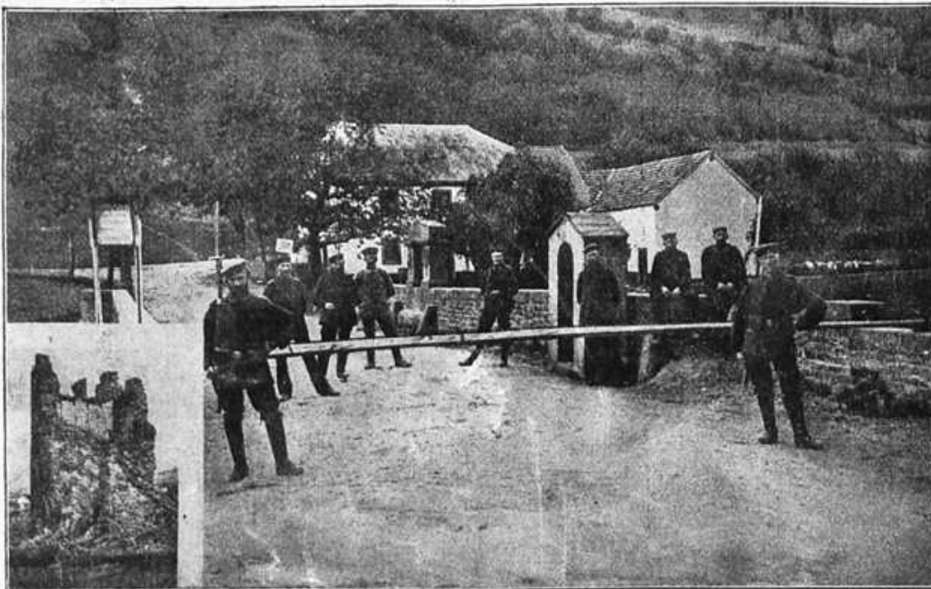
Grenzwaache an der Ourbrücke bei Dasburg.
